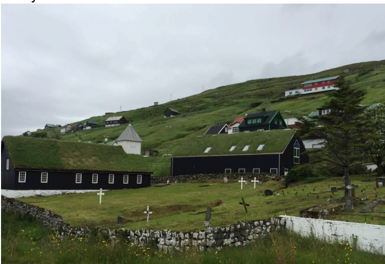
Häuser mit natürlichen Baustoffen auf den Faröer
