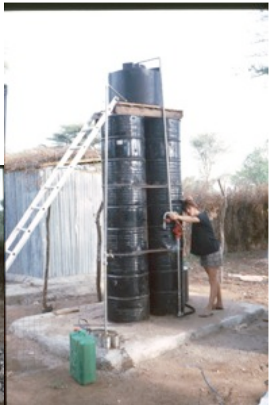
Der Wasserturm für Dusche und Küche.
