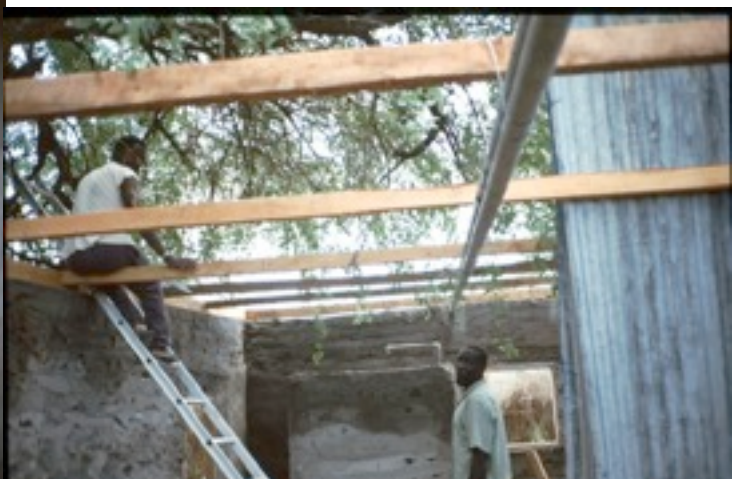
Das Dach kommt vor der Regenzeit drauf
